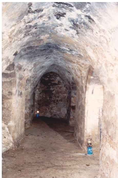
Couloir central à la fin des travaux
