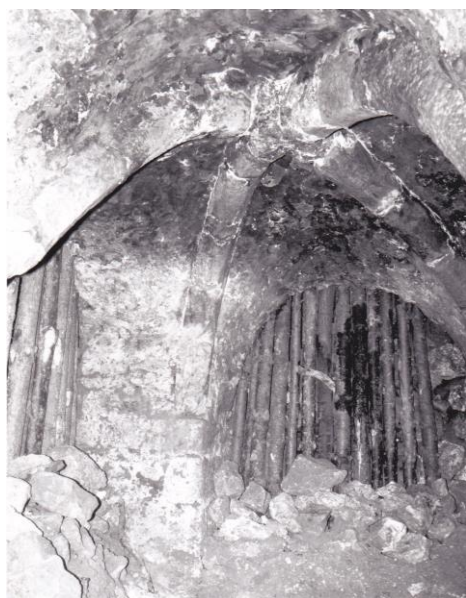
Le boisage avant reconstruction des murs
