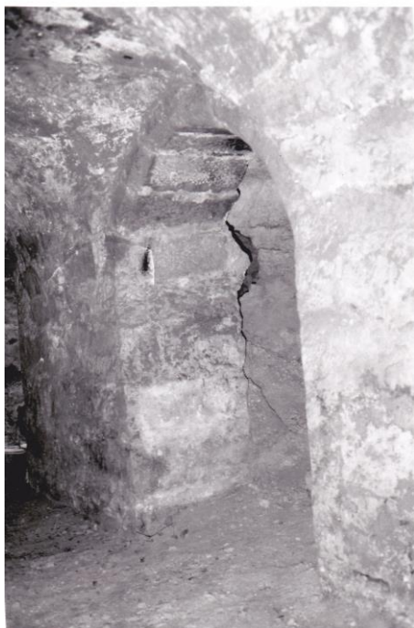
Arc maçonné ouvrant sur un alvéole
