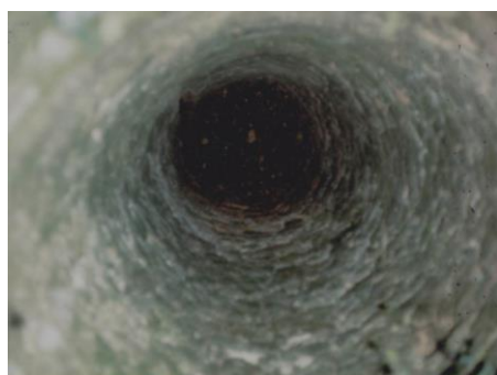
Cuvelage du puits en 1988
