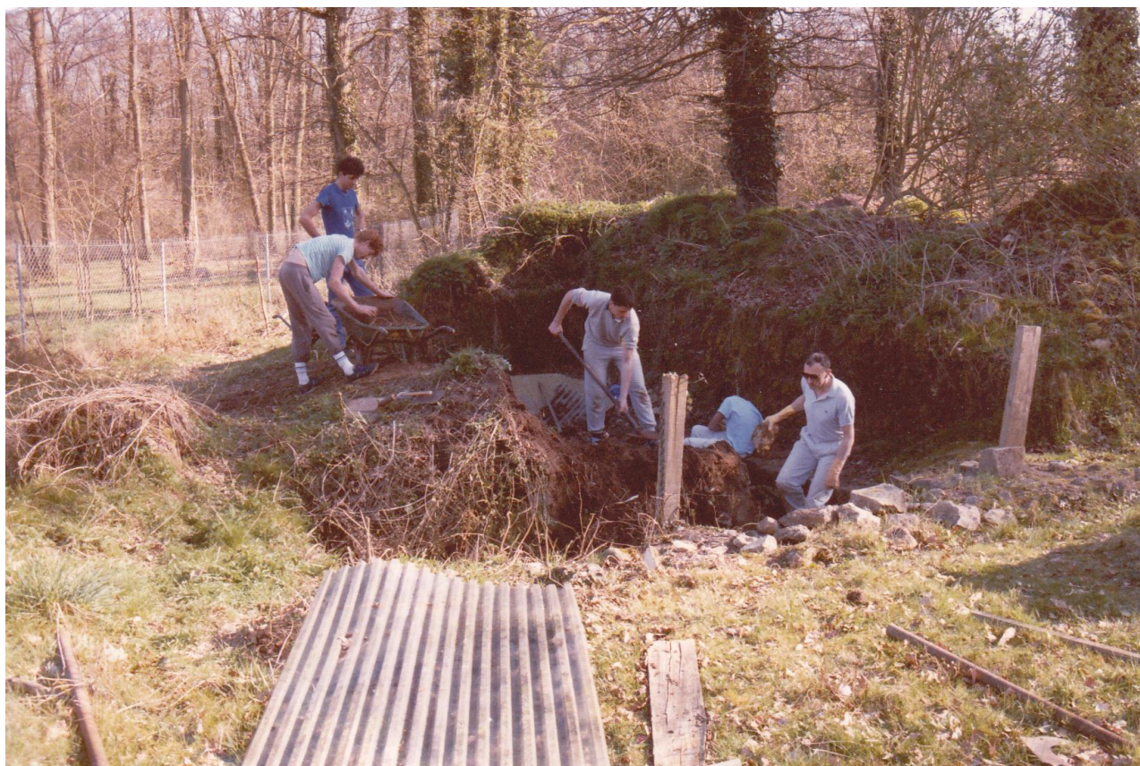
Début du chantier
