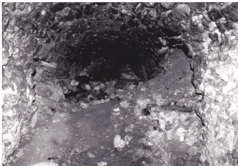
Couloir de descente au début des travaux ➔
