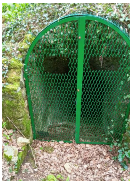
Grille mise en place par l'ONF
